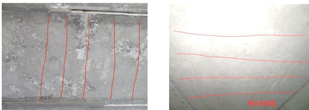
图 5.2.7 跨中横向裂缝
