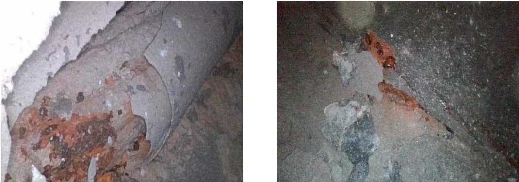
图 5.2.12 钢束锈蚀
