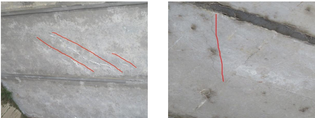
图 5.2.10 梁底（非梁端）斜向裂缝
