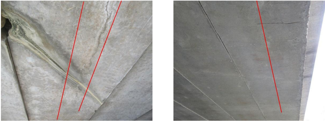
图 5.2.9 梁底纵向裂缝
