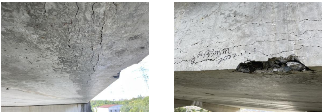
图 5.2.11 梁底或腹板网状裂缝
