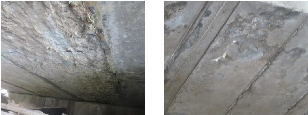
图 5.2.13 混凝土碳化
